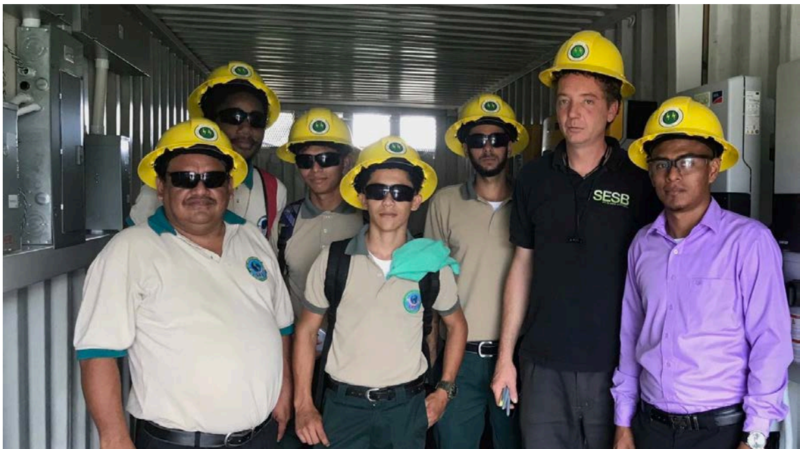
Abbildung 21: Besichtigung des Solar Mini Grid in La Gracia (Bild: SESB)
