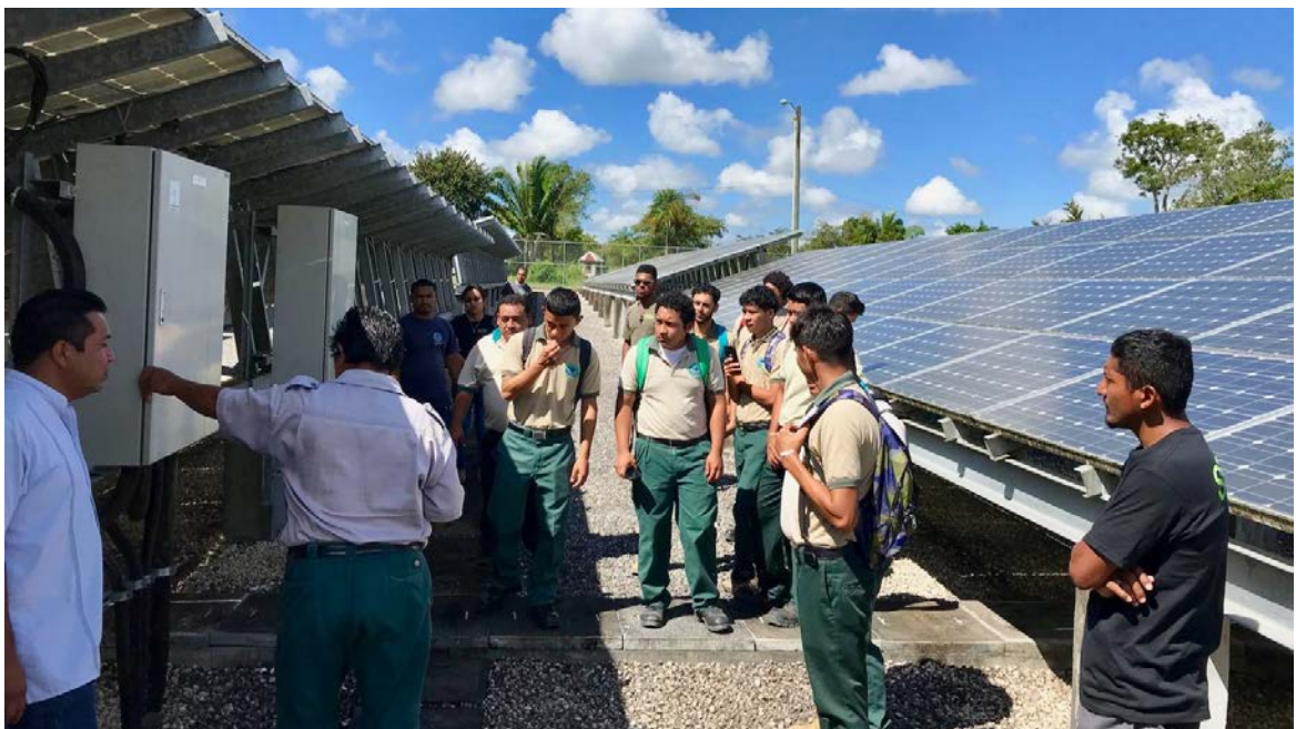
Abbildung 17: Besuch der grössten Solaranlage bei der Universität von Belmopan (Bild: SESB)
