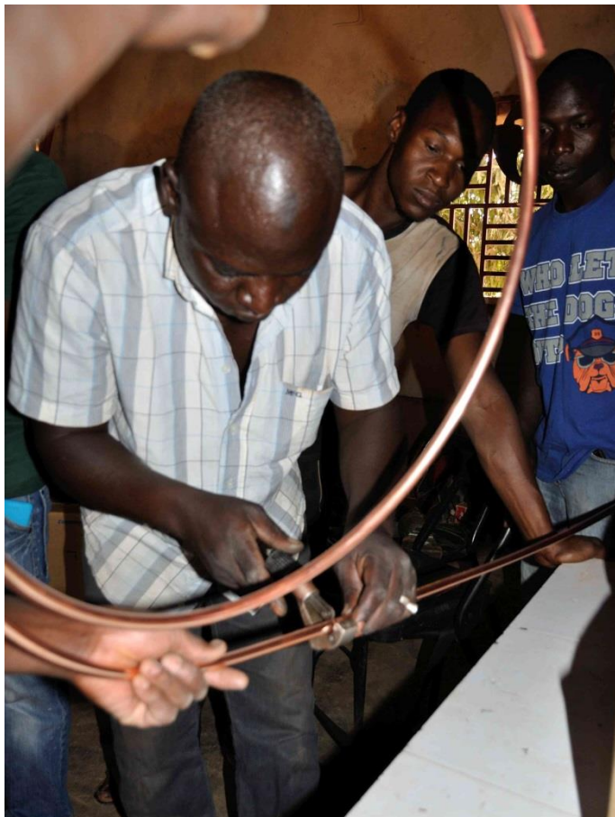
Bild 5: Richtige Handhabung des vorhandenen Equipments
