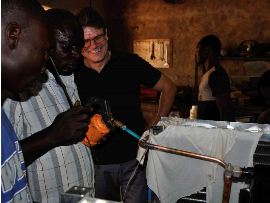
Bild 3: Lötarbeiten am WPT unter fachkundiger Aufsicht eines NTB-Mitarbeiters
