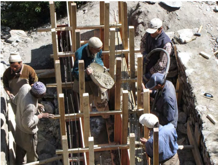
Abbildung 5 Betonierarbeiten am Turbinenfundament
