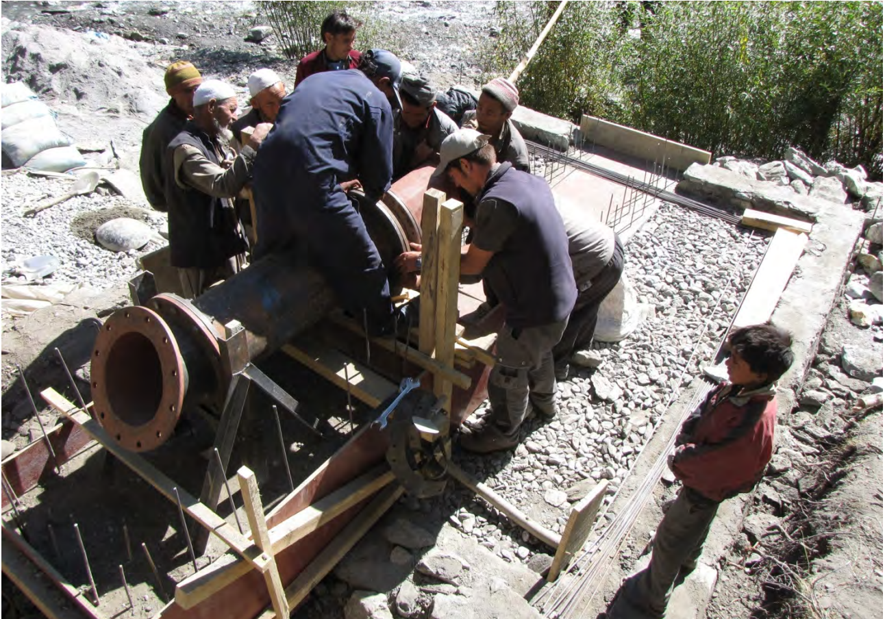
Abbildung 3 Ausrichten des Turbinenzulaufs
