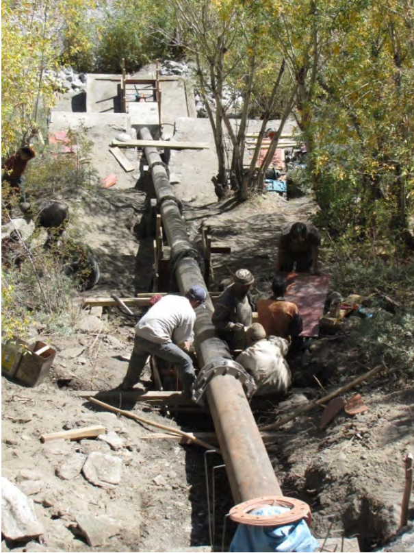
Abbildung 13 Druckleitungsmontage
