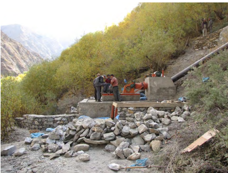
Abbildung 9 Turbinenfundation vor der Errichtung des Maschinenhauses
