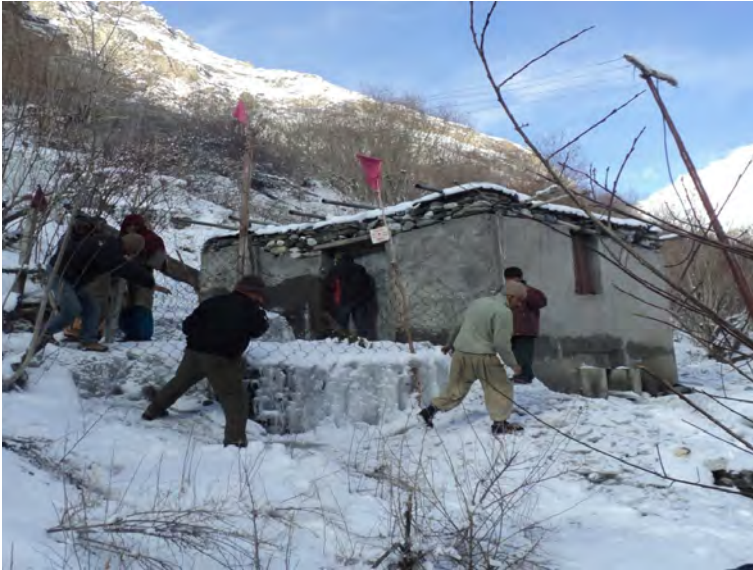
Abbildung 15 Maschinenhaus nach lokaler Bauweise
