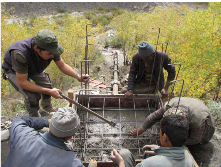
Abbildung 8 Betonierarbeiten eines Festlagers
