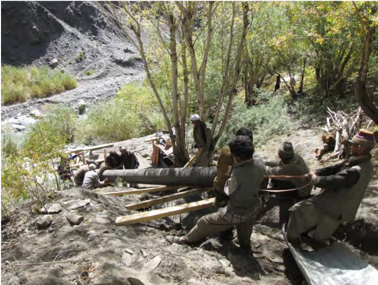
Abbildung 7 Montage der Druckleitung
