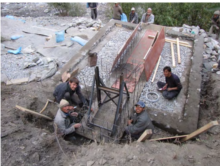
Abbildung 6 Armieren des unteren Festlagers
