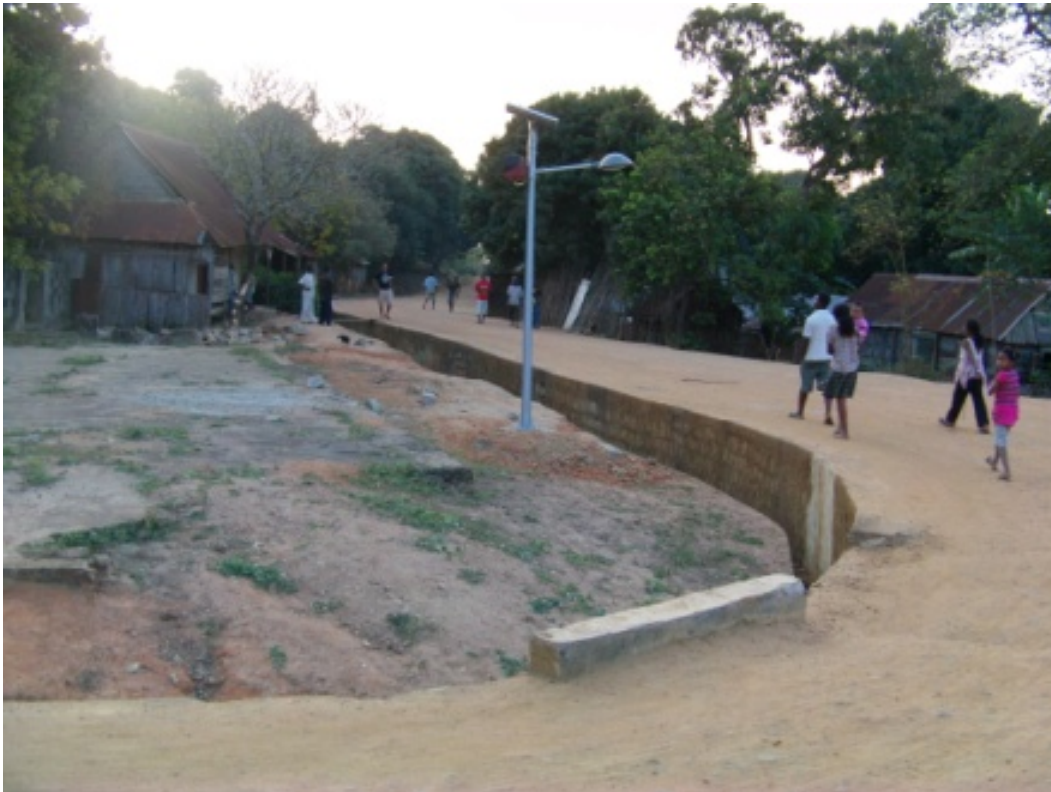
Solar-Lampe zur Strassenbeleuchtung im Dorf Soanierana (District of Fort Dauphin)
