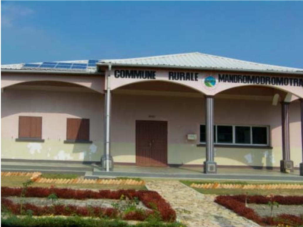
Solaranlage auf Bürgermeisteramt im Dorf Mandromondromotra (District of Fort Dauphin)
