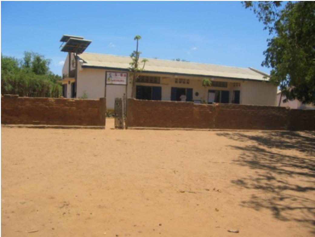
Solaranlage auf Gesundheitszentrum im Dorf Soanierana (District of Fort Dauphin)
