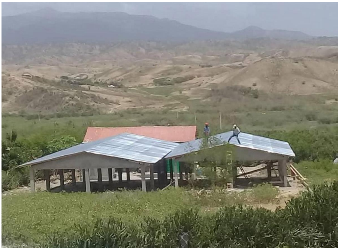
Bild 4: Gesamtansicht des ausgebauten Centre de Tri
