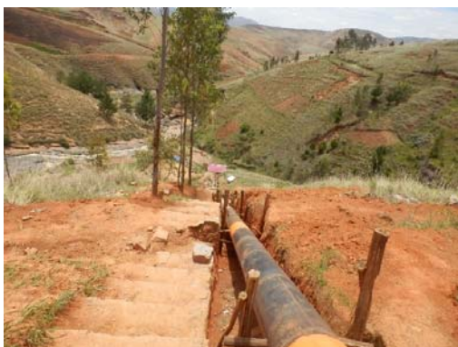
Figure 7: Confection, fabrication et mise en place de la conduite forcée par des mains d'œuvres locaux
