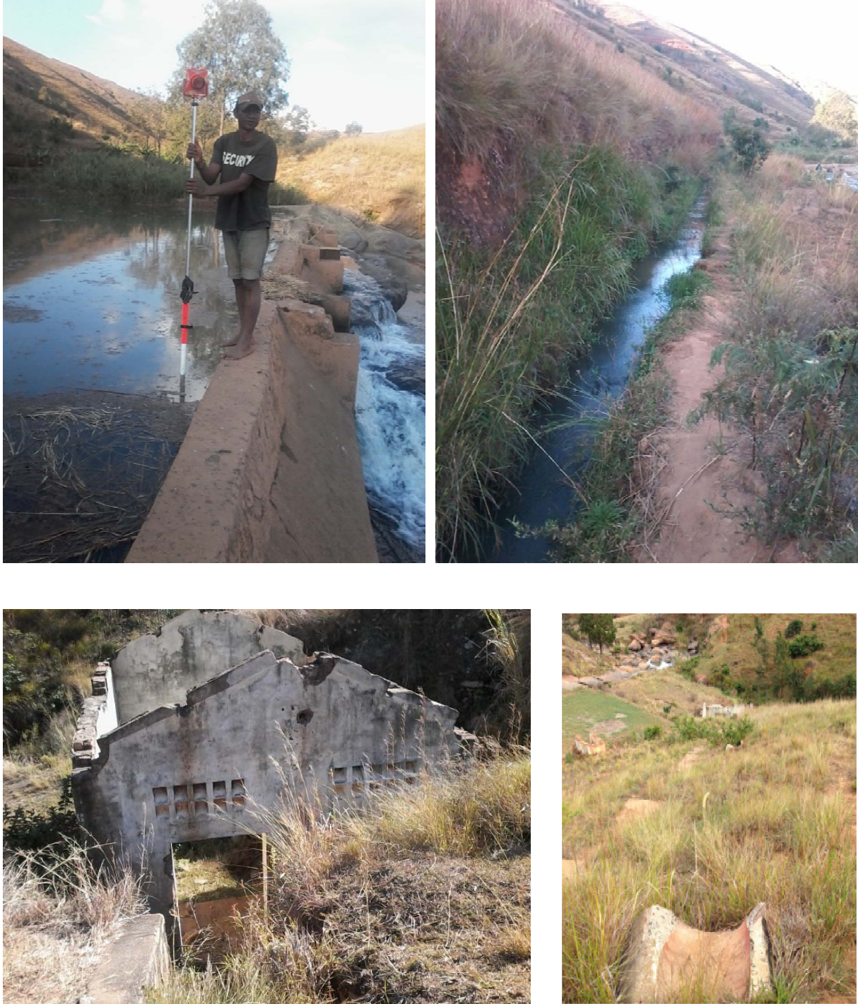
Figure 2: Ancien barrage, canal d'aménée, le reste de la partie électromécanique et le bâtiment central
