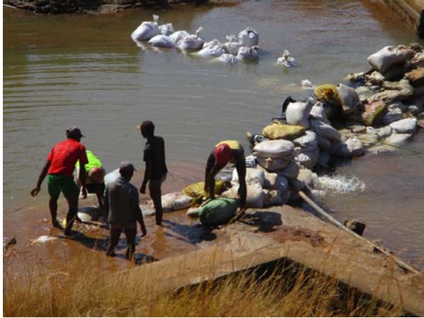
Figure 5: Mise en œuvre du barrage
