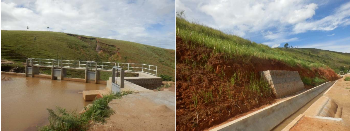
Figure 11: barrage hydroélectrique d'Andriamamovoka et canal d'amenée
