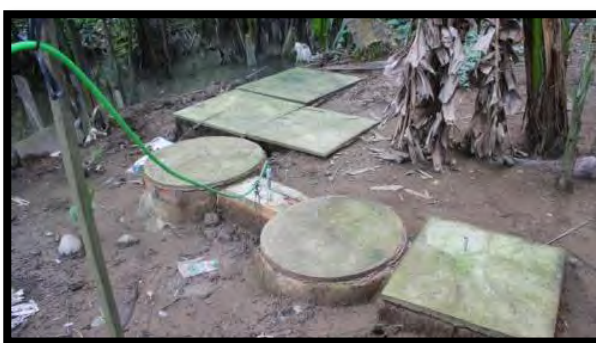
Exemple de fosse à biogaz
