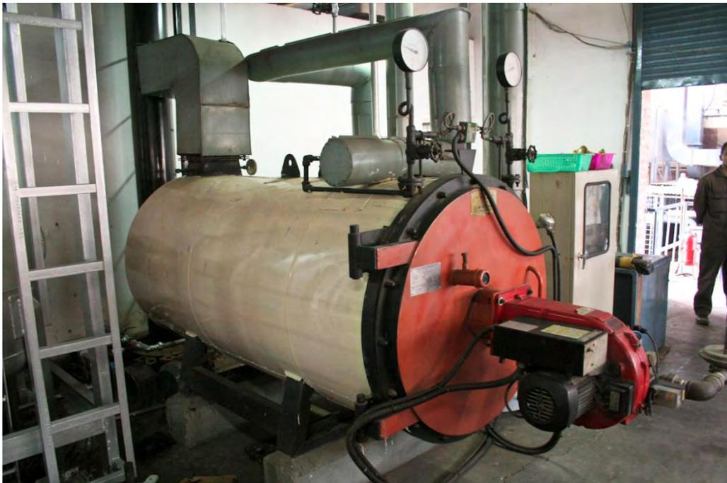
**Abbildung 17: Der Thermalölboiler ist täglich 24 Stunden in Betrieb**
