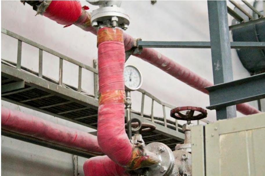
**Abbildung 22: Die Isolierung der Wärmeleitungen ist an den meisten Stellen mangelhaft**
