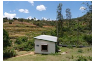
La centrale, entourée de rizières
