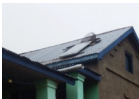
Un panneau solaire sur un toit d'Andriatsiazo-atsimo
