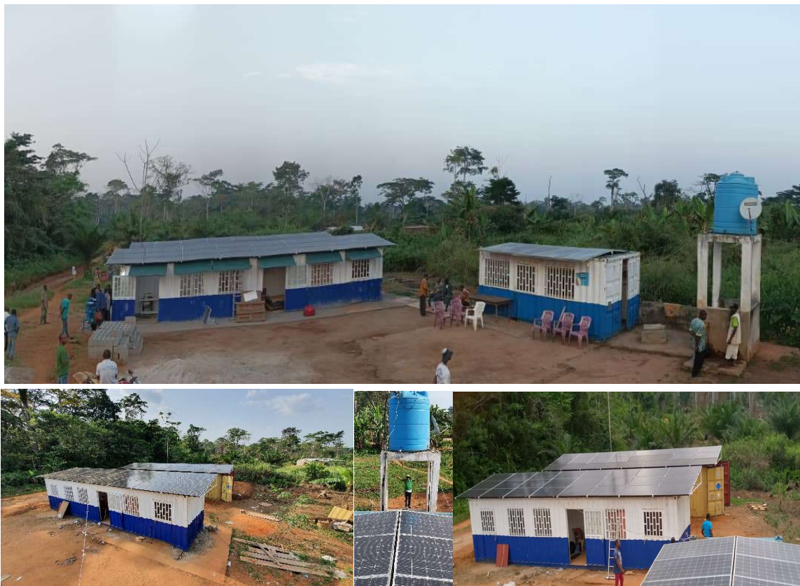
Figure 1 : vue de la Plateforme Energétique Rurale (PER)
