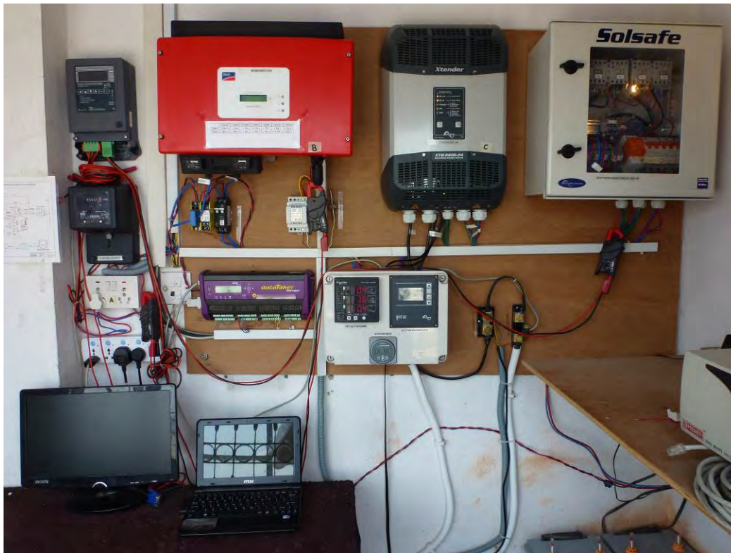
Figura 13: Inverter di rete, inverter bidirezionale Studer, sistema Solsafe e strumenti di misura presso la sede RIDS-Nepal a Imadol, distretto di Lalitpur (P3).
