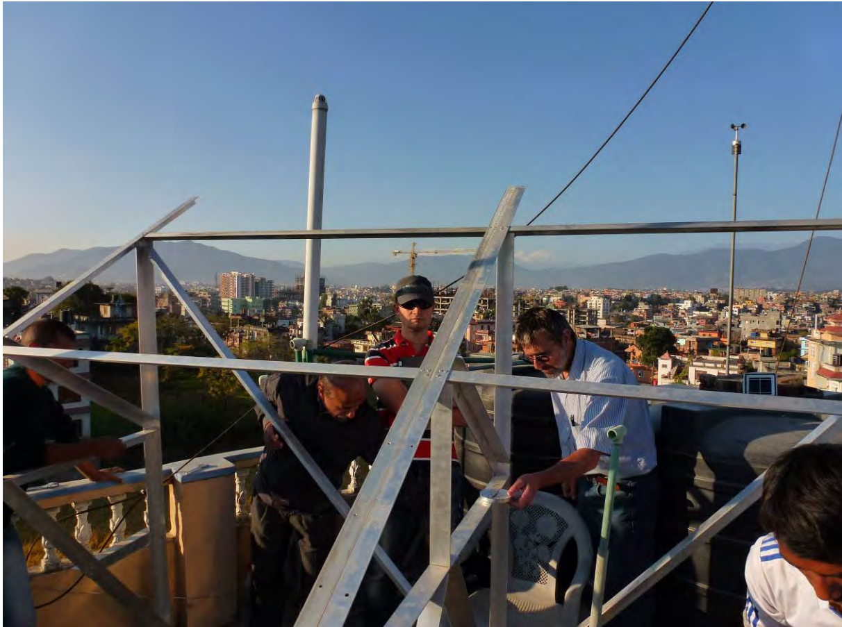
Figura 17: Posizionamento della struttura portante in P3 durante le fasi della costruzione.
