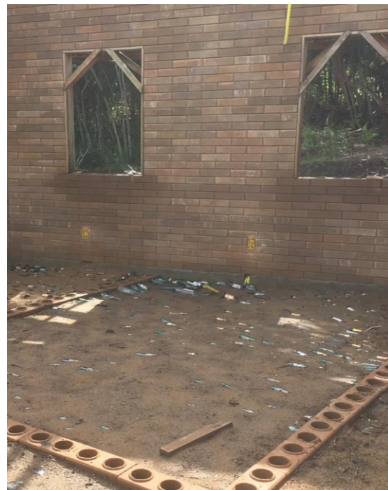
Abb. 8 Nach dem Auffüllen mit Sand
