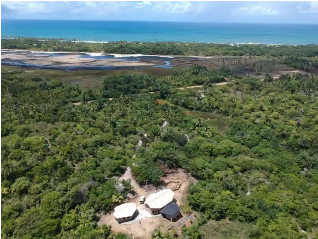
Abb. 7: Escola MarAmar aus der Luft. Die PV-Panels sind noch nicht montiert. Bei der Einfahrt sind die beiden Solarlampen erkennbar. Auf der kleinen Anhöhe am linken Bildrand soll der Kindergarten entstehen.
