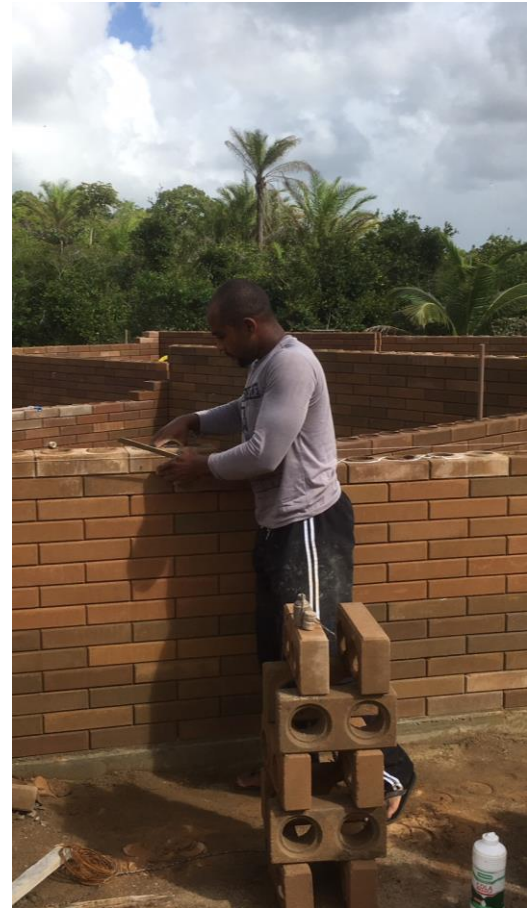
Abb. 11 und 12: Mauerbau mit den lokal produzierten Ziegelsteinen unter Verwendung von Holzleim (der sich für diesen Zweck als das beste Verbindungsmittel herausgestellt hat)
