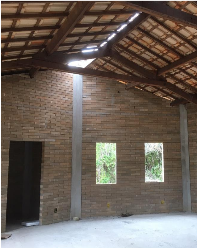
Abb. 9: Schulzimmer kurz vor der Inbetriebnahme
