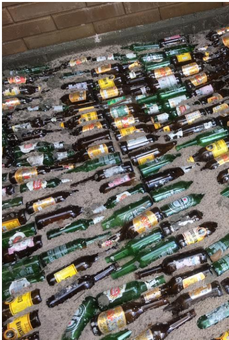
Abb. 7: Flaschen als Füllmaterial
