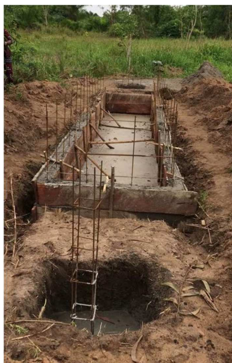
Ferrailage et coulage du béton des ouvrages de l'installation de méthanisation
