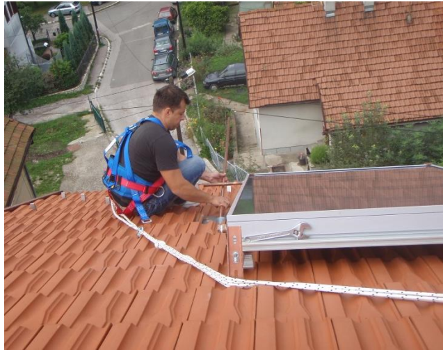
Abbildung 9: Befüllen der Solaranlage.
