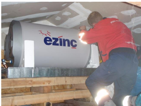
Abbildung 10: Installation des Warmwasserspeichers unter dem Dach. Bild rechts, mit zusätzlicher Dämmung des Speichers im sonst ungedämmten Dach. Bild links ohne zusätzliche Dämmung des Speichers da das Dach bereits gedämmt war.
