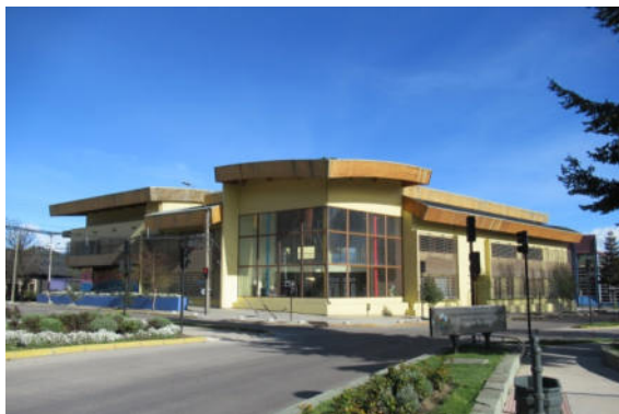
Das Centro Cultural als markanter Eingang zum Stadtzentrum
