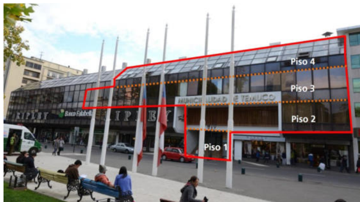
Komplizierte Eigentumsverhältnisse am Edificio Consistorial (die rote Linie bezeichnet den Teil der Gemeinde)
