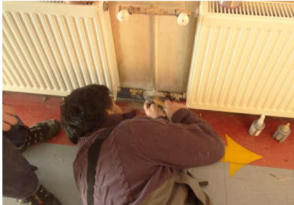
Erneuerung der Wärmeverteilung
