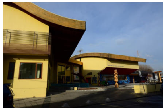
Komplizierte Bauformen prägen das Gebäude. Alle Wände sind ungedämmt
