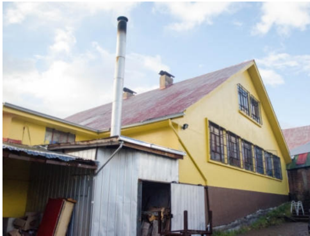
Das Colegio Baquedano mit Heizzentrale vor der energetischen Erneuerung
