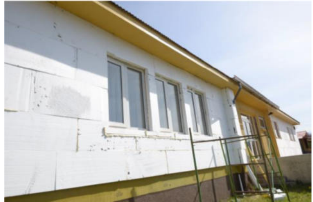
Noch unverputzte Aussendämmung
