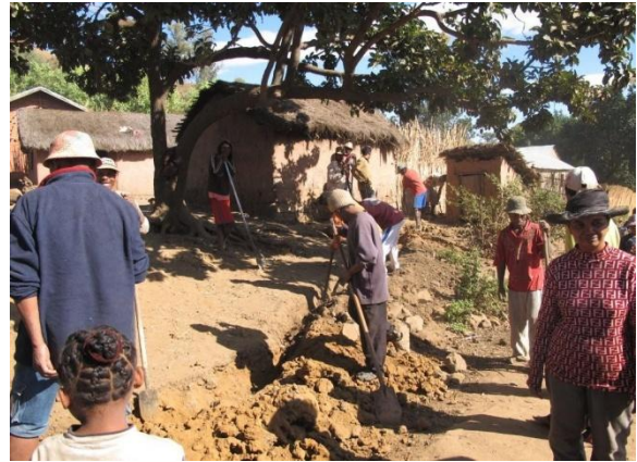
Travaux pour enterrer le réseau
