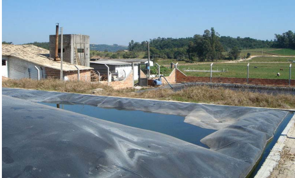
Abbildung 6: Biogasanlage der Firma Trigas (Gasfolienhaube im Vordergrund mit nachfolgender Güllelagerung und Technikgebäude am linken Bildrand)
