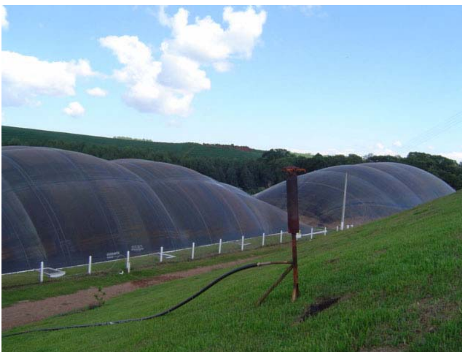
Abbildung 18: Biogasnutzung auf der Fazenda von Sadia in Faxinal dos Guedes
