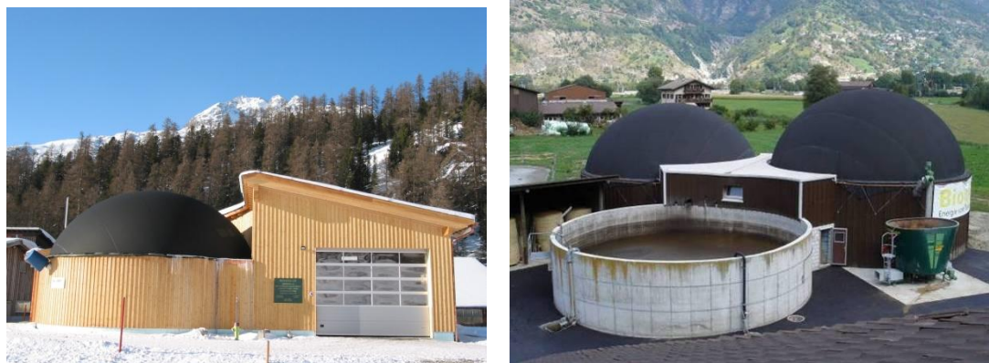
Abb.1: Biogasanlagen in Silvaplana (GR), und in Visp (VS)
