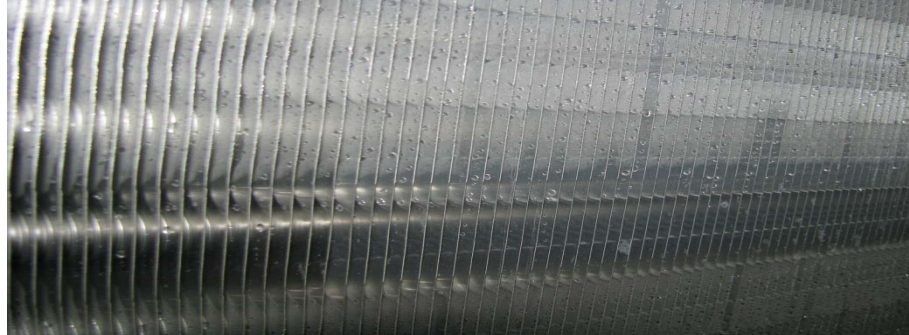
Abbildung 13: Kondenswasserbildung auf dem Verdampfer
