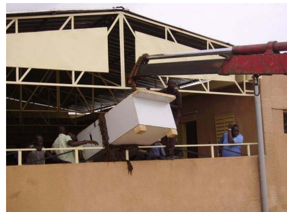
Abbildung 16: Die robuste Konstruktion lies grösseren Schaden am Trockner vermeiden.
