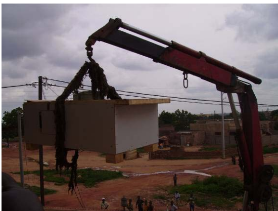
Abbildung 15: Der Unterbau wurde mit einem alten Lastkran an den Bestimmungsort gesetzt.
