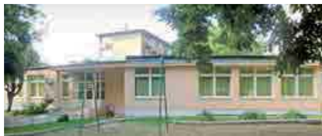
Nouvelles fenêtres, toiture et façade : dans le cadre des cours, les étudiants ont rénové des bâtiments hébergeant des jardins d'enfants publics. La photo montre le résultat de la deuxième session de cours.
