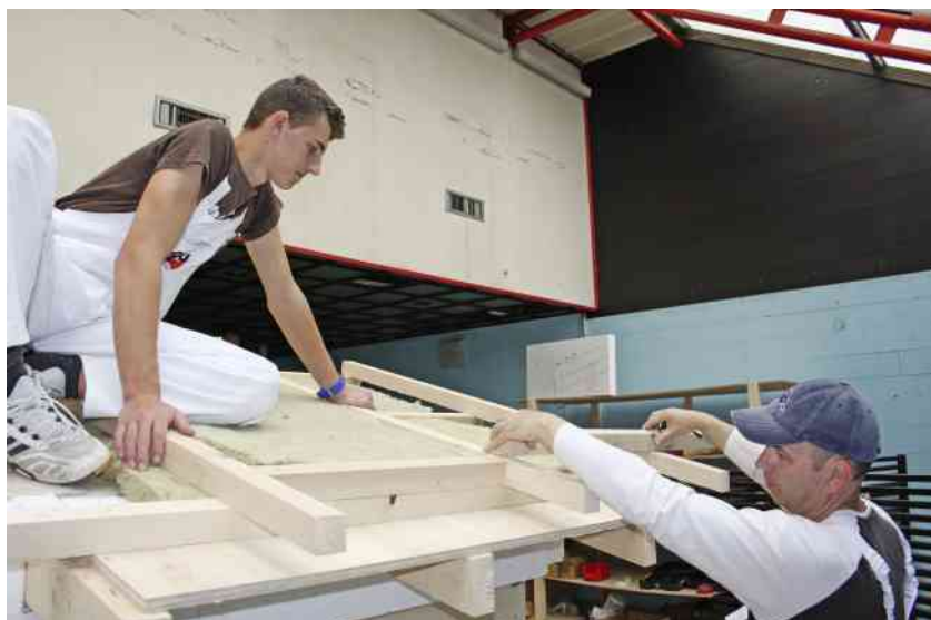
Praktisches Training nach Schweizer Vorbild: Zwei der Studenten üben das richtige Dämmen von Gebäudefassaden und Dächern an einem Werkstattmodell.
