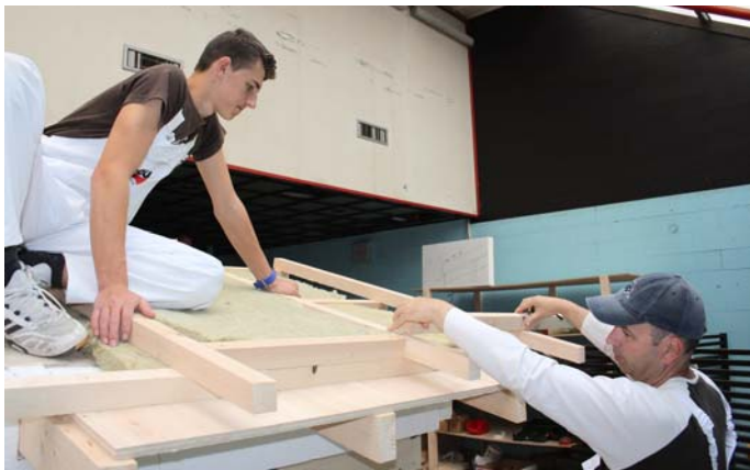
Une formation pratique calquée sur le modèle suisse: deux étudiants s'exercent sur un modèle d'atelier leur permettant de tester concrètement l'isolation des façades et des toitures de bâtiments.
