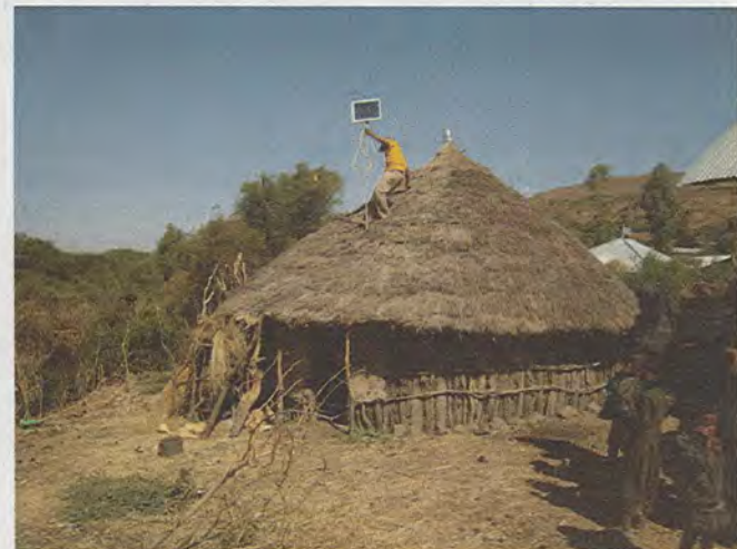
Dank den Solar-Home-Systemen stehen den Bewohnern täglich mindestens vier Stunden Licht zur Verfügung. Damit können sie nach Einbruch der Dunkelheit weiter lernen oder arbeiten. Die Installation der Solar-Home-Systeme auf den Runddächern ist aber nicht immer ganz einfach.
