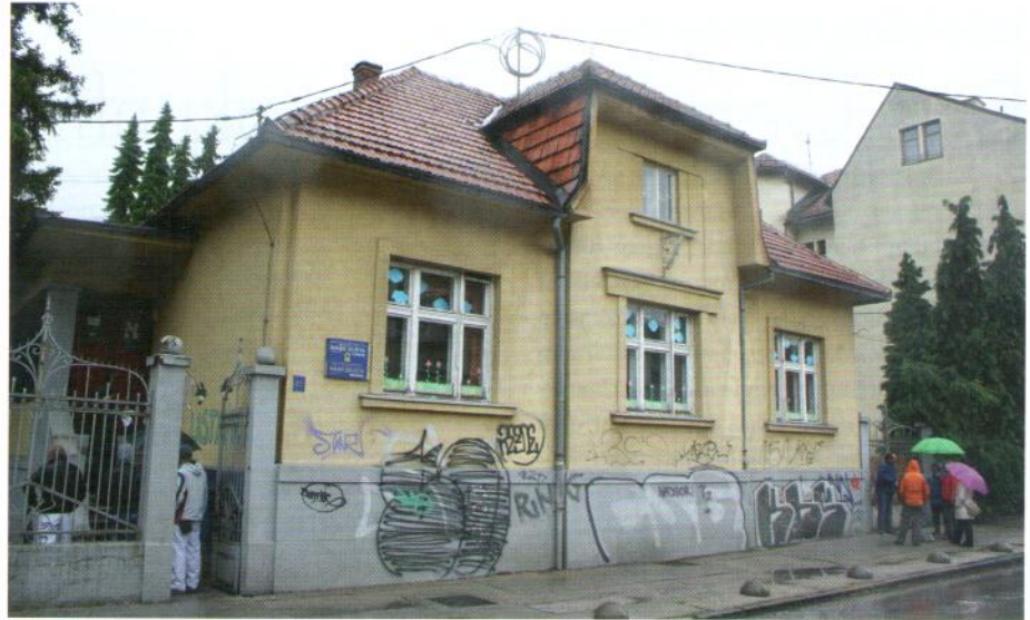
Vorher: Im Rahmen des ersten Kurses sanierten die Studenten ein Kindergartengebäude. Die Gebäudehülle mitsamt Dach wurde erneuert und genügt nun strengen ökologischen Kriterien. Quelle: CEE
