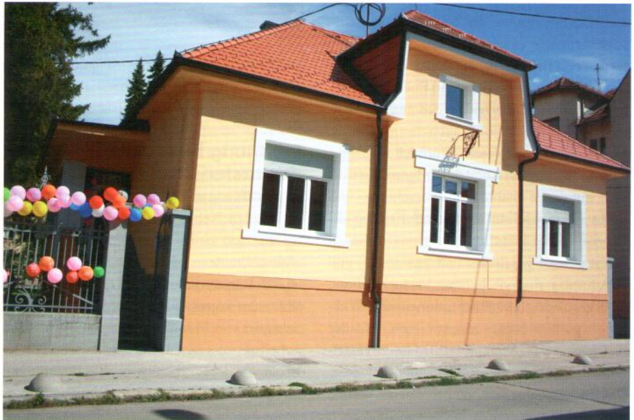
Nachher: Im Rahmen des ersten Kurses sanierten die Studenten ein Kindergartengebäude. Die Gebäudehülle mitsamt Dach wurde erneuert und genügt nun strengen ökologischen Kriterien. Quelle: CEE
